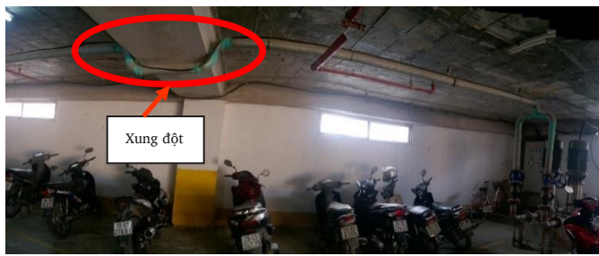
Hình 3. Một thiết kế xung đột trên bản vẽ 2D/CAD khi triển khai thi công không có sự thay đổi phù hợp.
