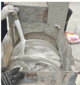
a) Hỗn hợp bê tông bọt được trộn trong máy trộn
