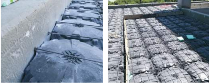
Hình 2.3. Dự án IstinyePark Izmir – Izmir, Thổ Nhĩ Kỳ Sàn bê bơi.
