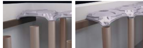
Hình 2.12. Lắp đặt tấm cốp pha nhựa biên.
