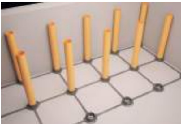
Hình 2.10. Lắp đặt hệ cột PVC. (Nguồn: Công ty ABS Yapi, Thổ Nhĩ Kỳ)
