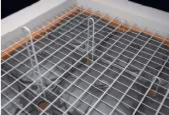
Hình 2.14. Lắp đặt lưới thép sàn và thép cột. (Nguồn:Công ty ABS Yapi, Thổ Nhĩ Kỳ)
