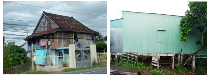
Hình 24. Nhà sàn được nâng lên thành lầu (a), Nhà sàn xây mới vách tôn (b) (Tác giả).
