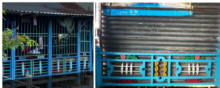
Hình 20. Khung sắt và tấm tôn được tích hợp thêm vào lan can (Tác giả).
