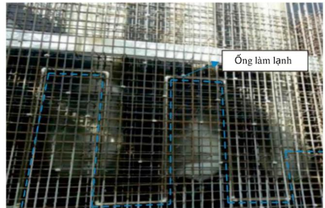
Hình 11. Hình ảnh bố trí và lắp đặt ống thoát nhiệt tại công trường [22].
