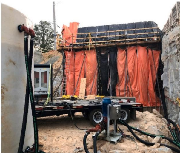
Hình 10. Hình ảnh thi công một công trình sử dụng hệ thống thoát nhiệt [17].
