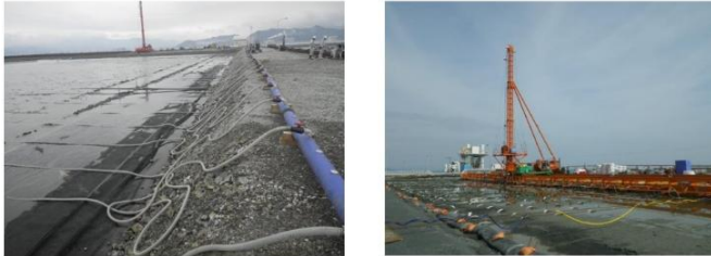
Hình 1. Mô hình thi công gia cố đất bùn bằng thoát nước và hút chân không tại Nhật Bản [14].
