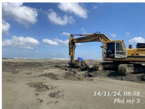
b) Nạo vét và tập kết vật chất nạo vét
