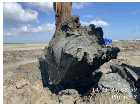
b) Nạo vét và tập kết vật chất nạo vét
