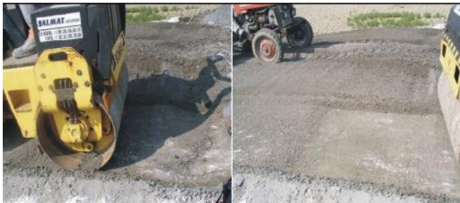
Hình 2. Công tác thi công, sử dụng bùn nạo vét tại cảng biển Bessin, Pháp [14].
