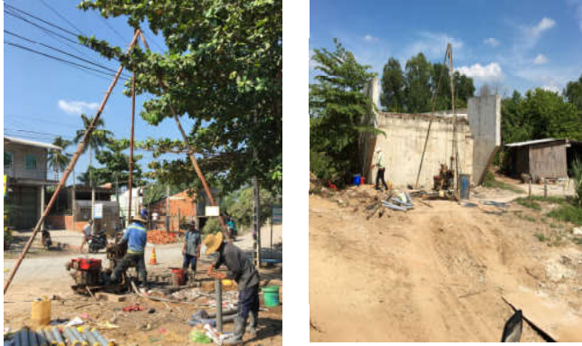
Hình 1. Khoan lấy mẫu đất nguyên dạng.
