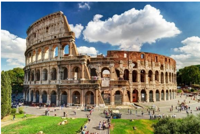
Hình 12. Đấu trường La Mã trong quá trình được trùng tu.
