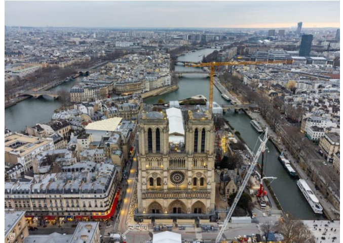
Hình 13. Nhà thờ Đức Bà Paris trong quá trình sửa chữa.
