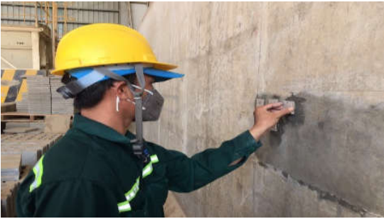
Hình 4. Tạo mẫu thử nghiệm trên tường bê tông.
